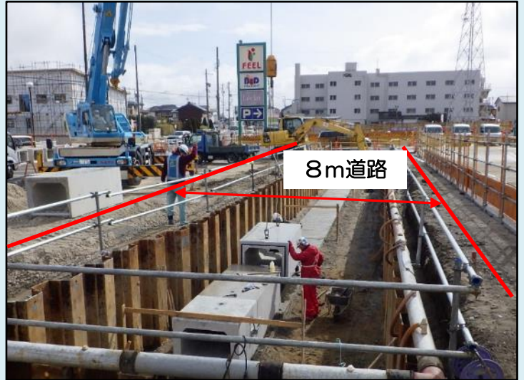
写真2 (道路内排水路の工事状況)
