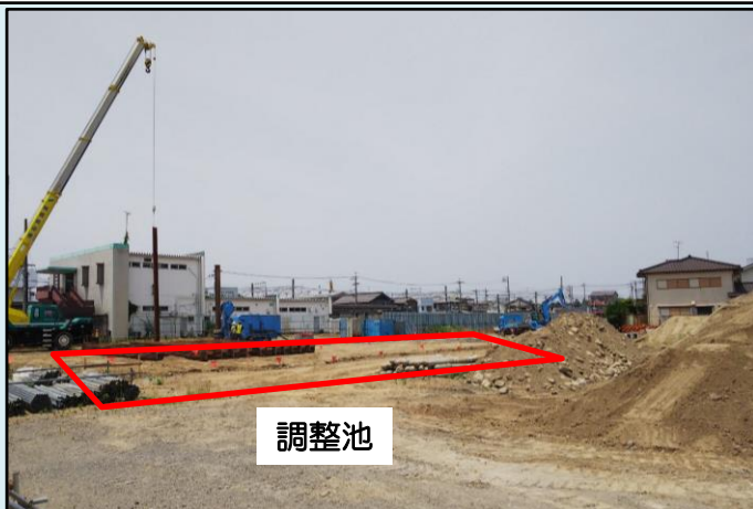
写真4 (調整池工事状況)
