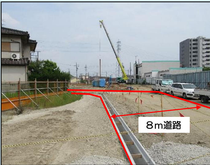
写真3 (8m道路工事状況)
