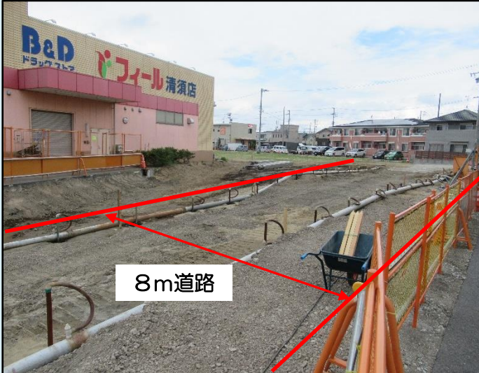
写真1 (8m道路工事状況)
