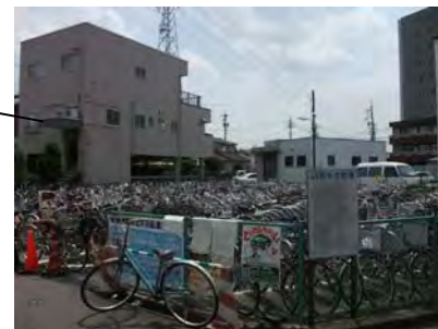
図 3 新清洲駅北自転車駐車場
