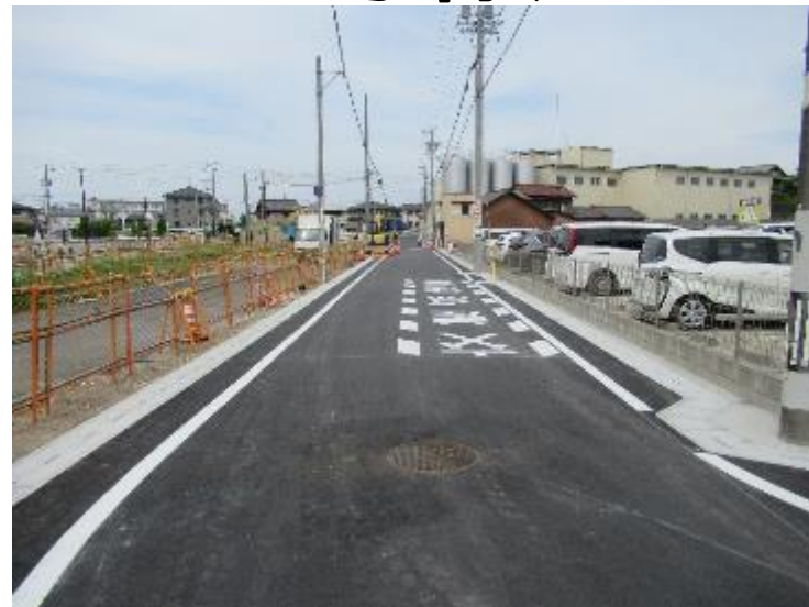
写真4 (完成した区6-2号道路)
