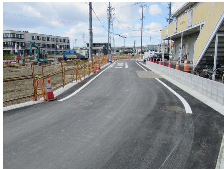
写真6 (完成した区6-2号道路)
