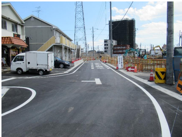
写真5 (完成した区6-2号道路)
