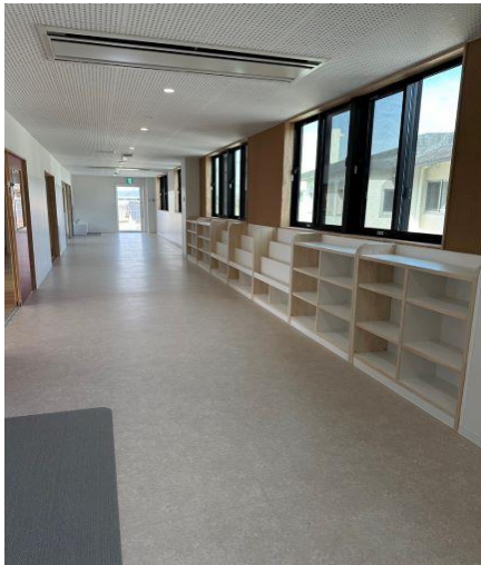
増築棟2階廊下
