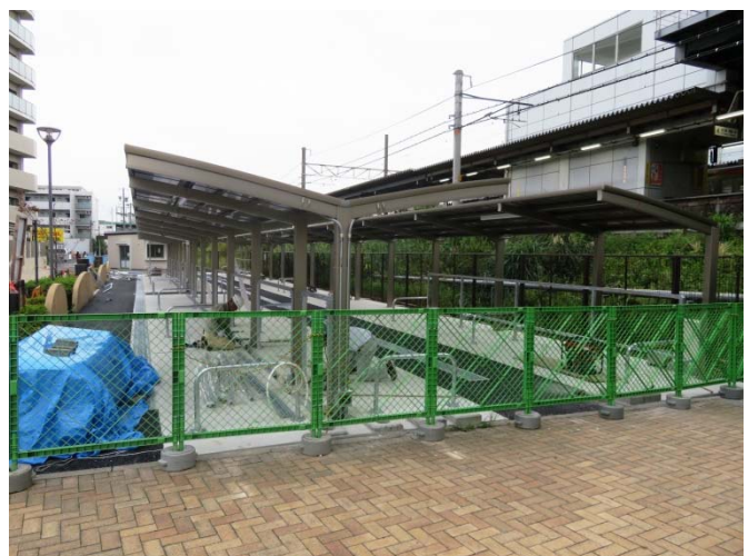
建設中の枇杷島駅東口(南側)自転車等駐車場
