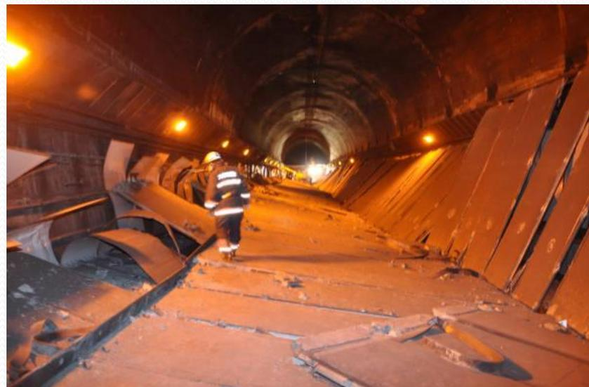
トンネルの天井板が落下し、9人が死亡。原因は天井板を支えていた吊り構造部分の劣化だった。
