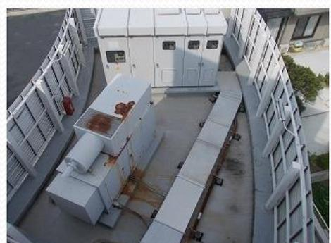
電気設備：架台の錆（健全度C）
