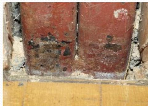
躯体：鉄骨の腐食（健全度C）
