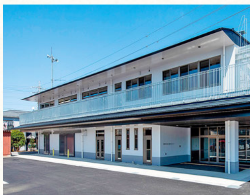
五条川防災センター開所(R6)
