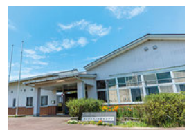
庄内川水防センター
