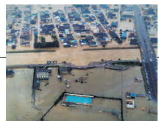
東海豪雨 新川破堤(平成12年9月)
