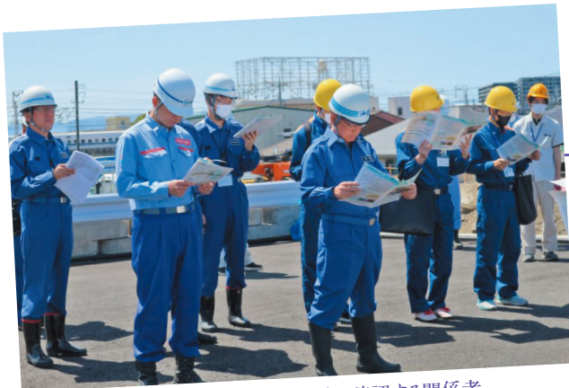
枇杷島橋改築工事の進捗を確認する関係者
