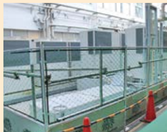
設置工事中の室外機
