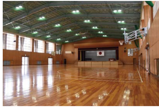
▲空調設備を設置する小中学校体育館
