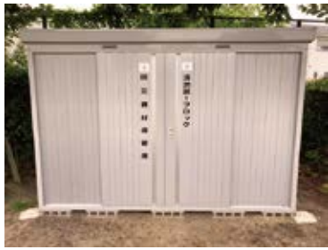
▲整備した備蓄倉庫
