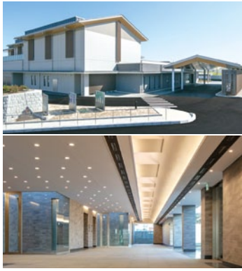
(上段)五条川斎苑外観(北西面) (下段)施設内部(ホール)
