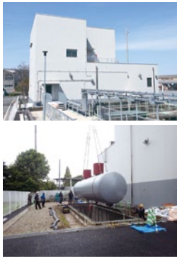
(上段)電気棟を新設(令和元年度) (下段)燃料タンクを設置(令和2年度) ※豊田川ポンプ場
