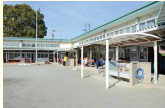
◆仮園舎を整備する一場保育園
