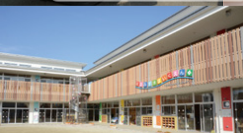
平成24年 花水木保育園竣工
