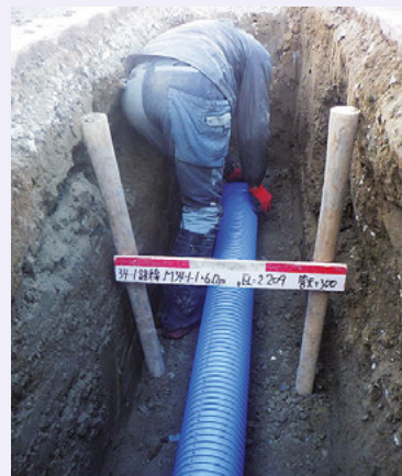
下水道敷設工事の様子
