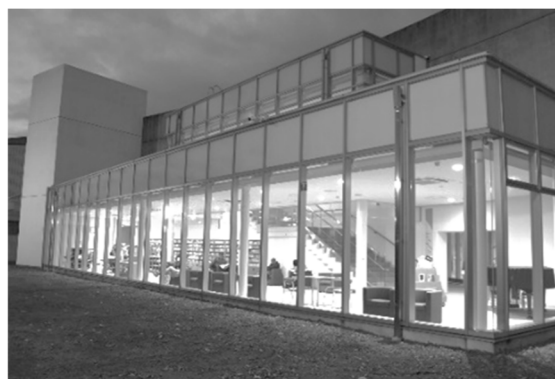
●清須市立図書館交流テラス外観
