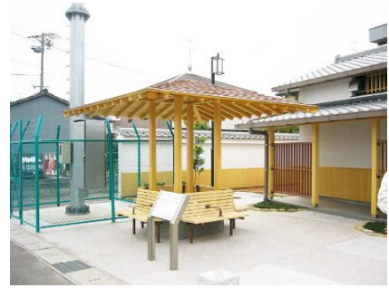
新川橋橋詰ポケットパーク
