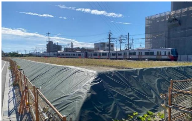
写真5 (仮線用地 東エリア)
