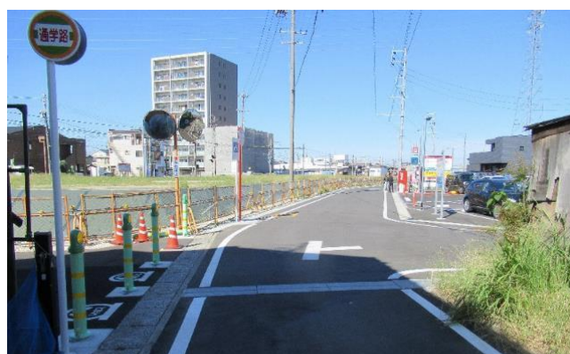
写真4（区画道路6-5号線） 船橋橋からの車両の通行が可能になりました。
