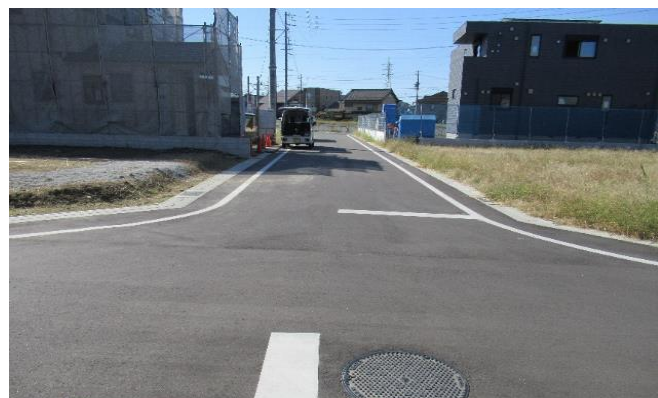
写真3（区画道路6-4号線） 新たに区画道路が整備されました
