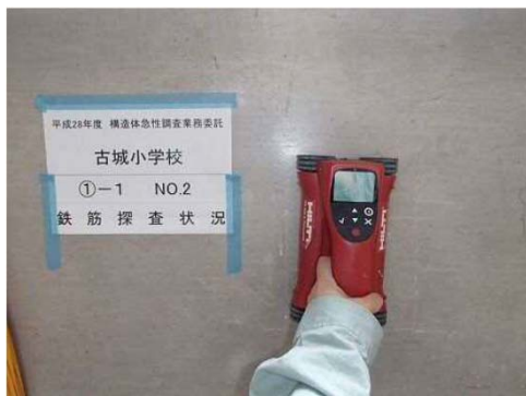
①コンクリート壁の調査
