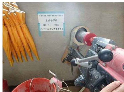
②コンクリート壁のコア抜き
