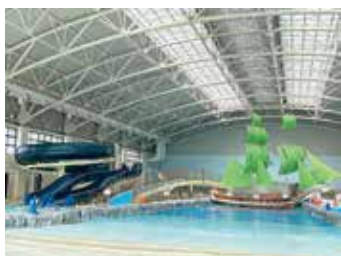
アルコ清洲プール
