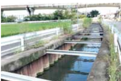
福田川第2号排水路
