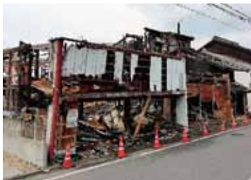
住宅密集地の火災現場
