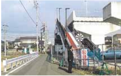
跨線橋の工事現場
