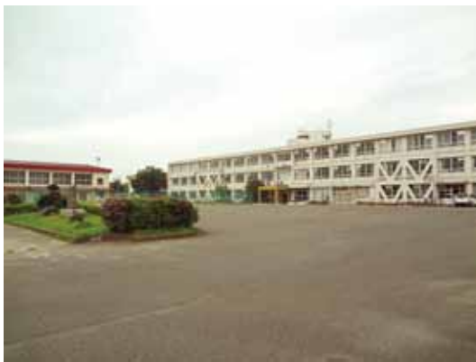
雨水貯留施設設置工事予定地(新川中学校)
