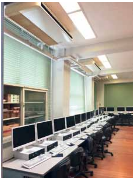
特別教室のエアコン設置
