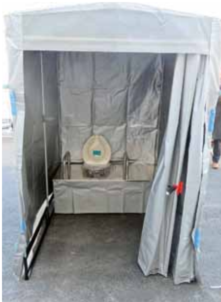
マンホールトイレ (西枇杷島小学校)
