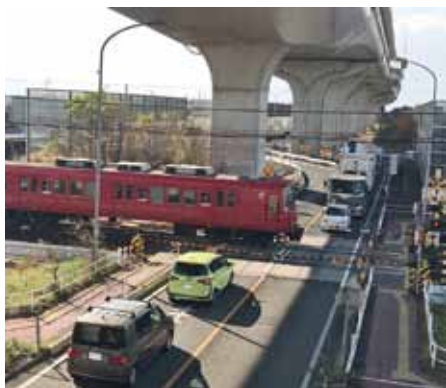
国道302号廻間踏切
