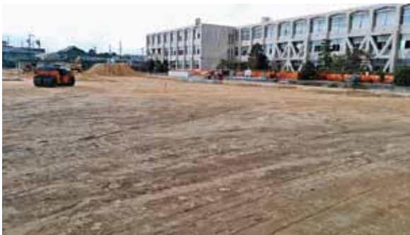
雨水貯留施設設置工事(古城小学校)
