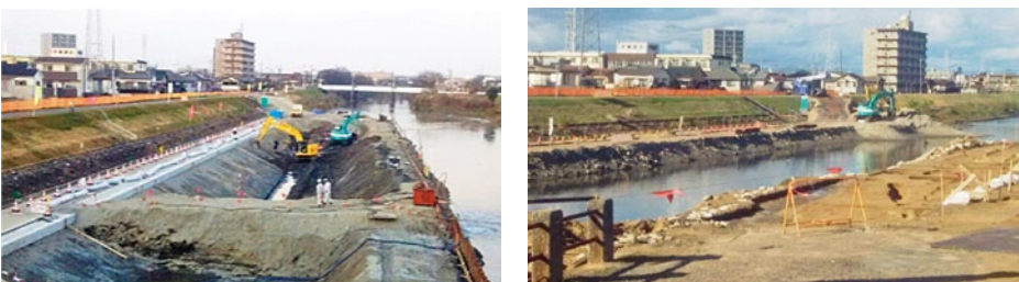
五条川(名鉄本線下流)改修工事
