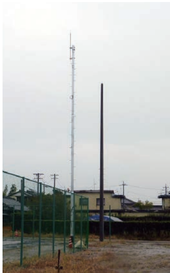
増設工事中の防災行政無線 (春日新橋西地区)
