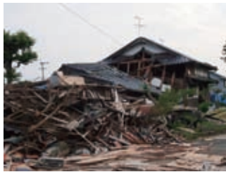
熊本地震被害状況(益城町): 出典 DELTA WORKS
