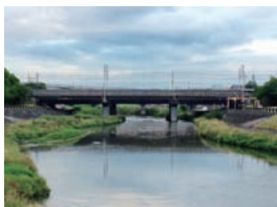
五条川橋梁 (新幹線)
