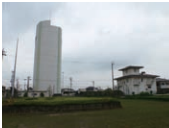
春日配水場施設
