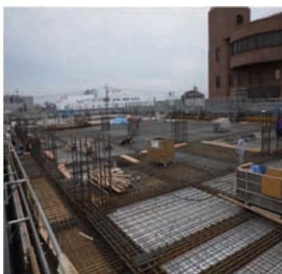
3階床スラブ配筋
