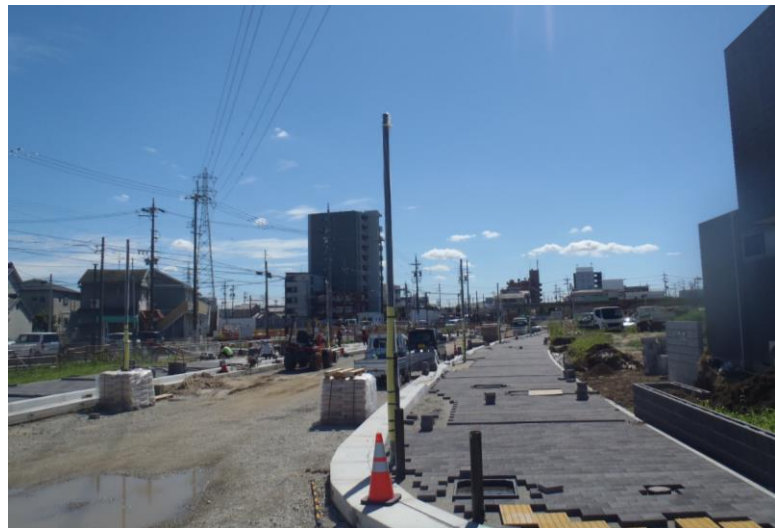
写真2 (新清洲駅前北線の工事状況)
