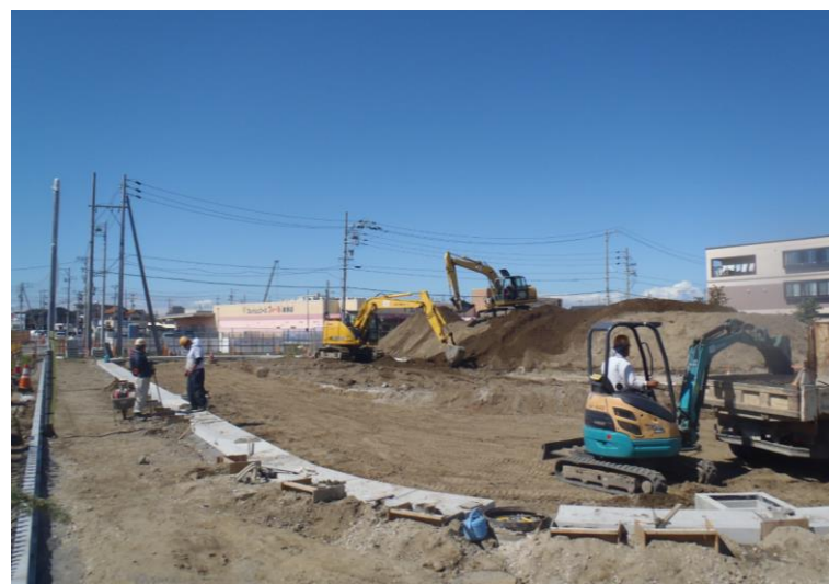
写真3 (駅前広場の工事状況)
