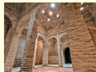
▲蒸し風呂の天井の星型開口部
