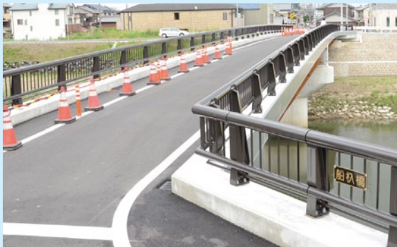
開通した船杓橋
