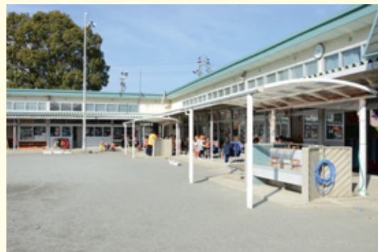
◆仮園舎を整備する一場保育園
