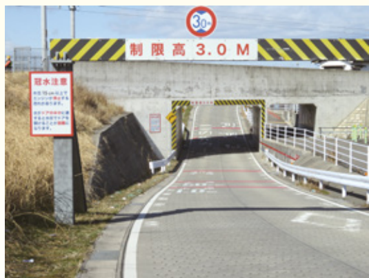
◆自動遮断機等を整備予定のアンダーパス
