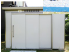
防災倉庫及び防災資機材
