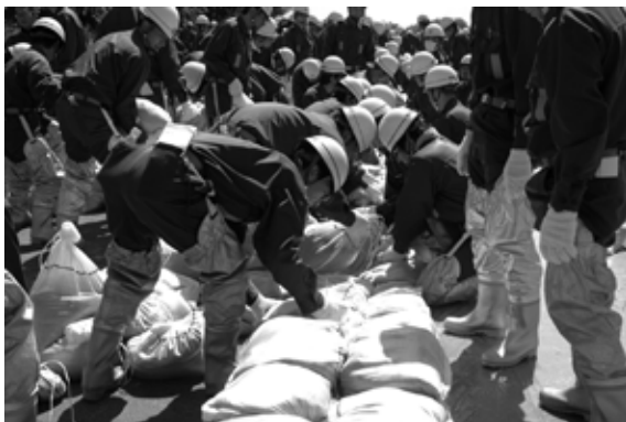
土のうを積み上げる消防団員
