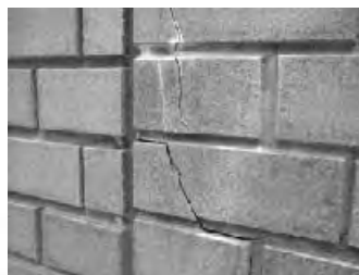
外壁クラック(ひび割れ)
