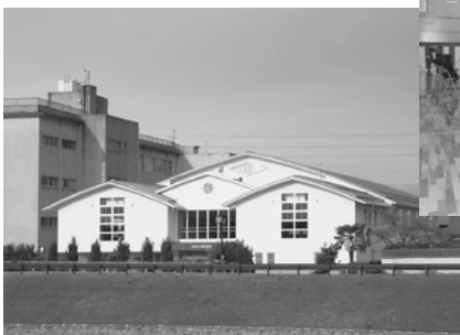
体育館の外観
