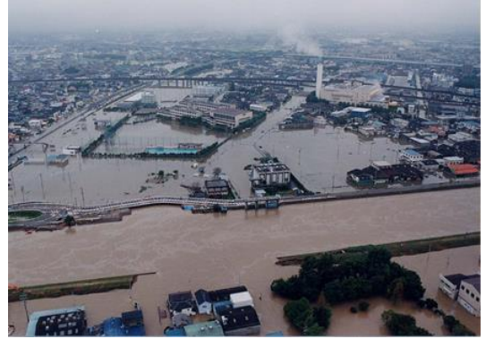
【東海豪雨による被災状況】
