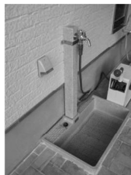
図 5-65 水受け槽の設置
